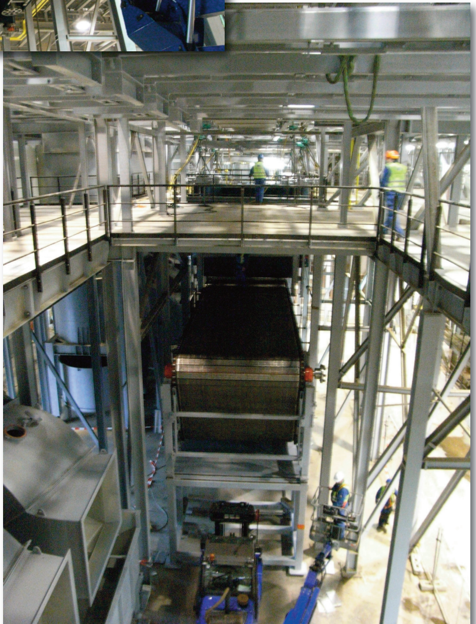
Die Verbringung der 52to schweren Einheit - bestehend aus Unterbau und Fasersammelband
