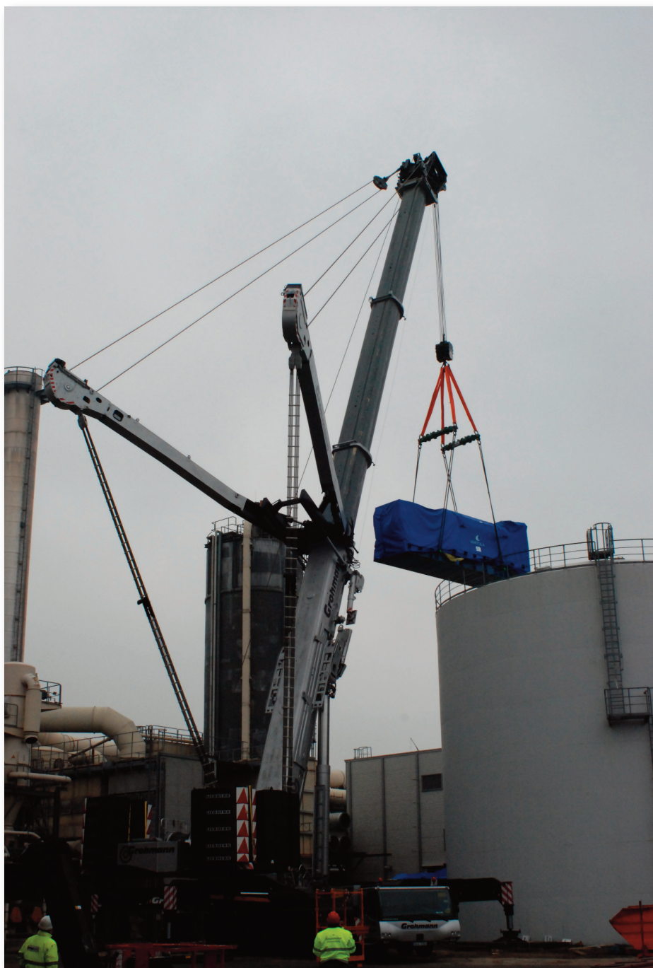
Scheinbar spielend hebt der weltweit leistungsstärkste 1.200 to Telekran die 105 to aus 25m Entfernung
